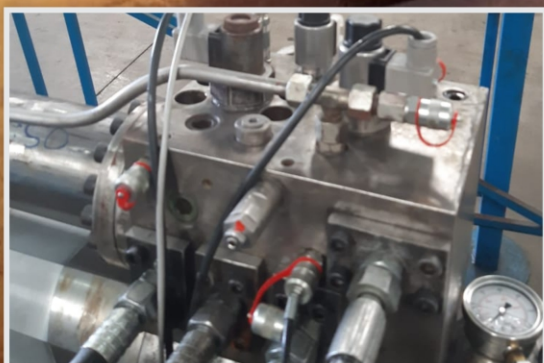
Manutenção de blocos manifolds de cilindros hidráulicos
